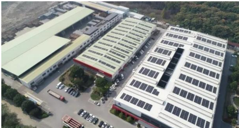
光伏发电设备
